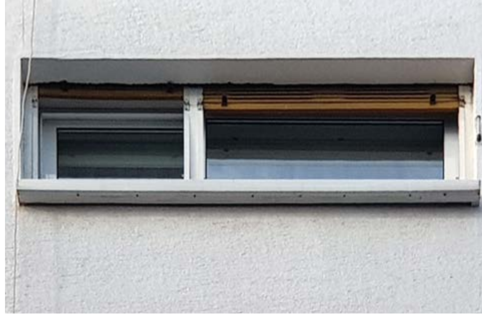
Ö. Faruk San'ın 1950'lerde tasarladığı, menteşeli kanat yanında temizlik için açılan vasistas pencere (Şükrü Kocağöz Arşivi)
